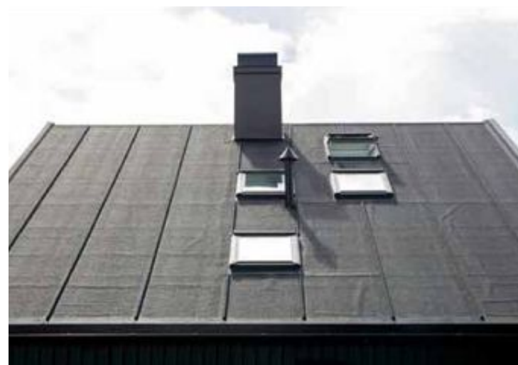
Takvinduer gir mer lys i andre etasje.
